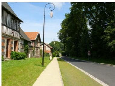
Le parking longitudinal a été réalisé en evergreen. Il était à l'origine recouvert d'enrobé, ce qui engendrait une impression de large route, ce qui est contradictoire avec le besoin de faire ralentir les véhicules. Sa mise en herbe crée un effet de resserrement visuel et limite par ailleurs les eaux de ruissellement.
