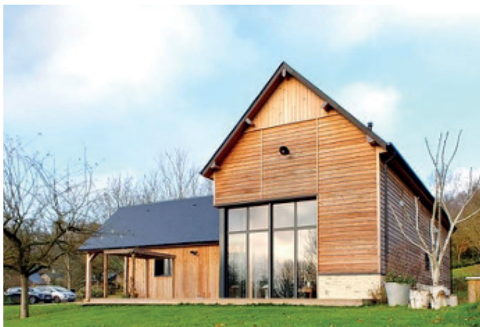
↑ Bardage clin à recouvrement rythmé verticalement.
