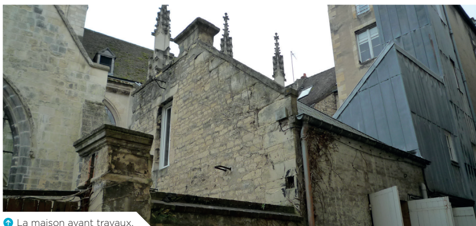
➔ La maison avant travaux.
