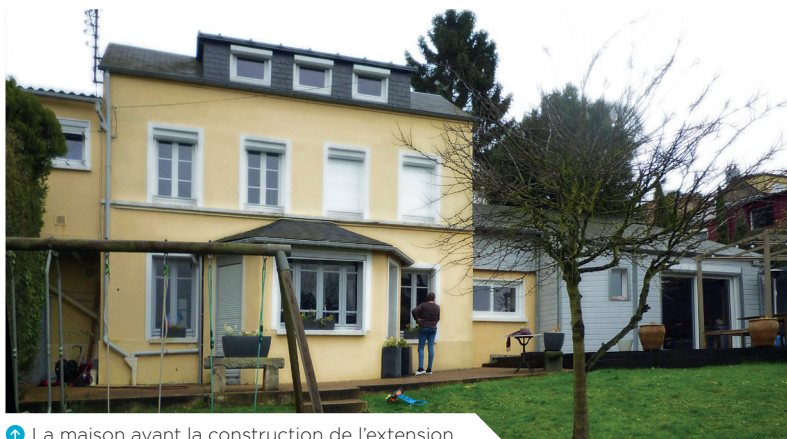
➔ La maison avant la construction de l'extension.
