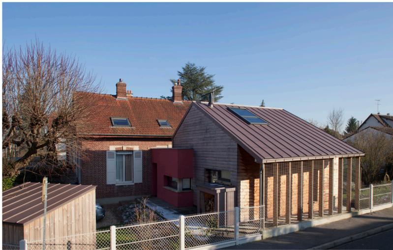
Le long du passage, une résille a été posée pour que la végétation s'y développe.
