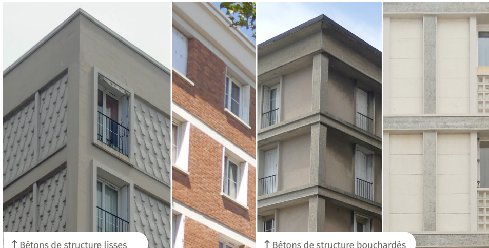
↑ Bétons de structure lisses
