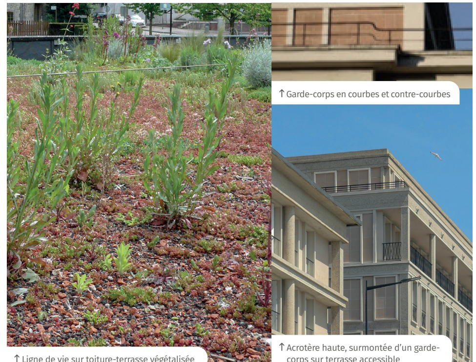
↑ Ligne de vie sur toiture-terrasse végétalisée
