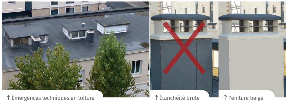
↑ Émergences techniques en toiture
