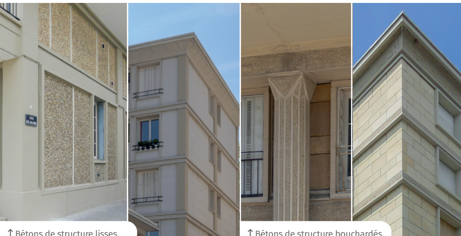
↑ Bétons de structure lisses
