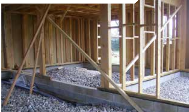
➔ Dalle en chaux-chanvre sur hérisson de galets.
