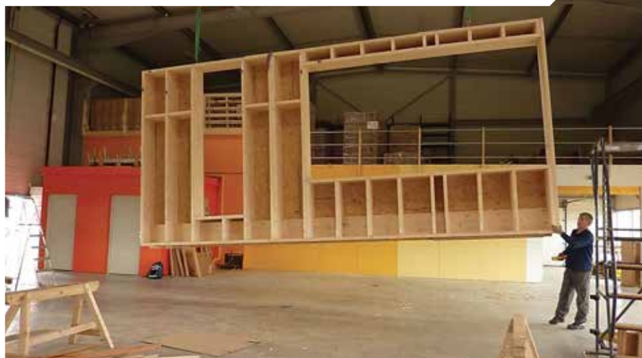
Les modules de façades sont préfabriqués en atelier pour répondre aux exigences de rapidité et contrôler la qualité de mise en oeuvre exigeante pour la paille
