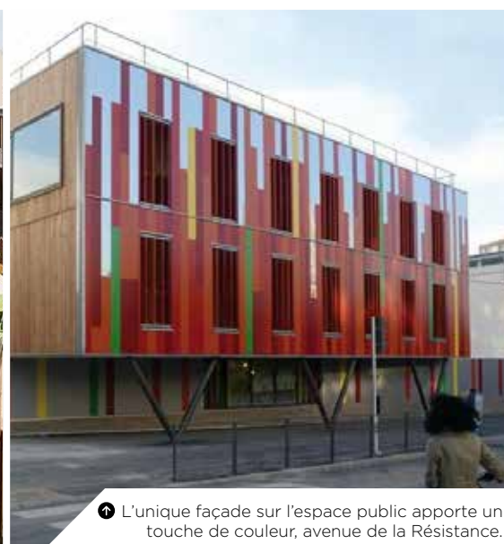
Les modules de façades sont préfabriqués en atelier pour répondre aux exigences de rapidité et contrôler la qualité de mise en oeuvre exigeante pour la paille
