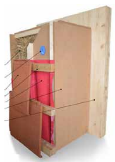
3 Maquette des caissons de façade rapportée
