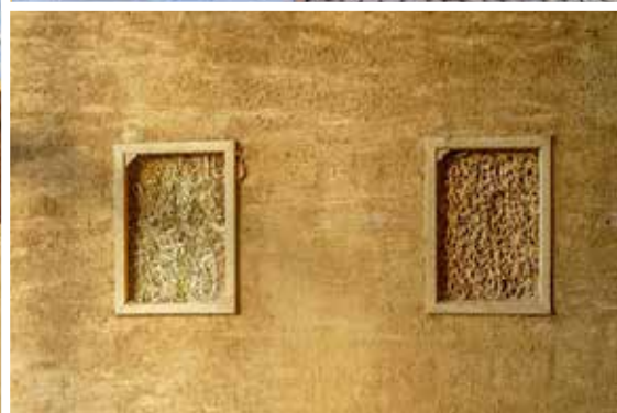
La matérialité des enduits terre et les fenêtres pédagogiques sur les matériaux de construction
