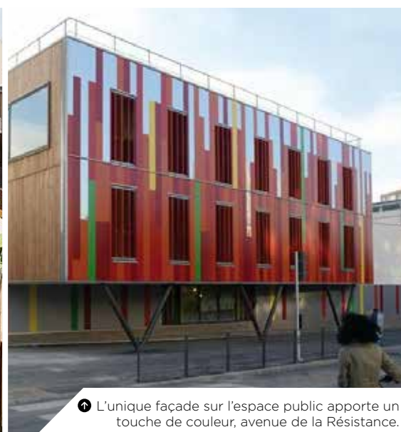
Les modules de façades sont préfabriqués en atelier pour répondre aux exigences de rapidité et contrôler la qualité de mise en oeuvre exigeante pour la paille
