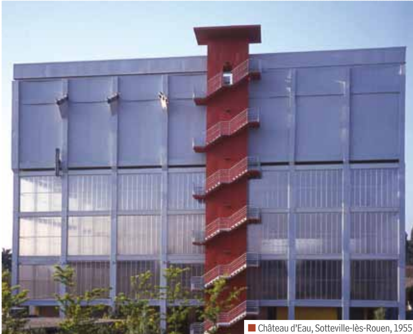
■ Château d'Eau, Sotheville-lès-Rouen, 1955
