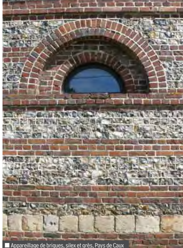
■ Appareillage de briques, silex et grès, Pays de Caux
