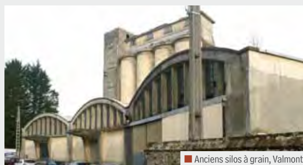
■ Anciens silos à grain, Valmont
