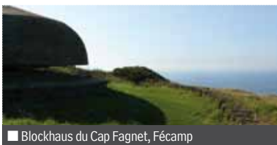
■ Blockhaus du Cap Fagnet, Fécamp
